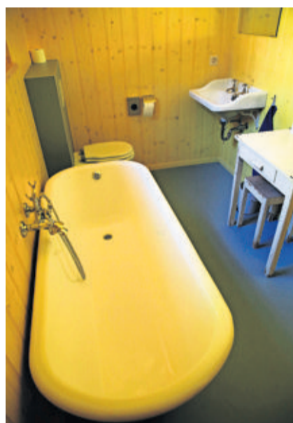
La salle de bains est d'époque et la baignoire d'origine a été réémaillée.
